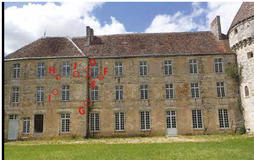
Les 7 sites de nidification sur la façade sud-est du bâtiment conventuel - Cliché Jean-Claude Poupart
